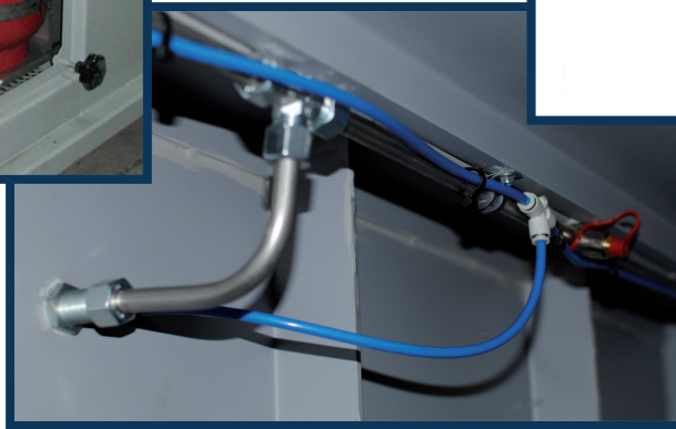
Puruimukontti varustettuna automaattisella sammutusjärjestelmällä ja ylitäytönestimellä.
