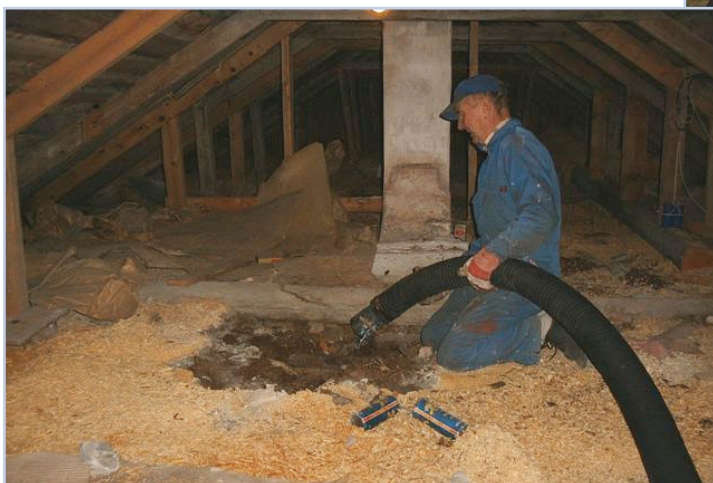
Purujen imurointia Eurovac perävaunuimurilla
