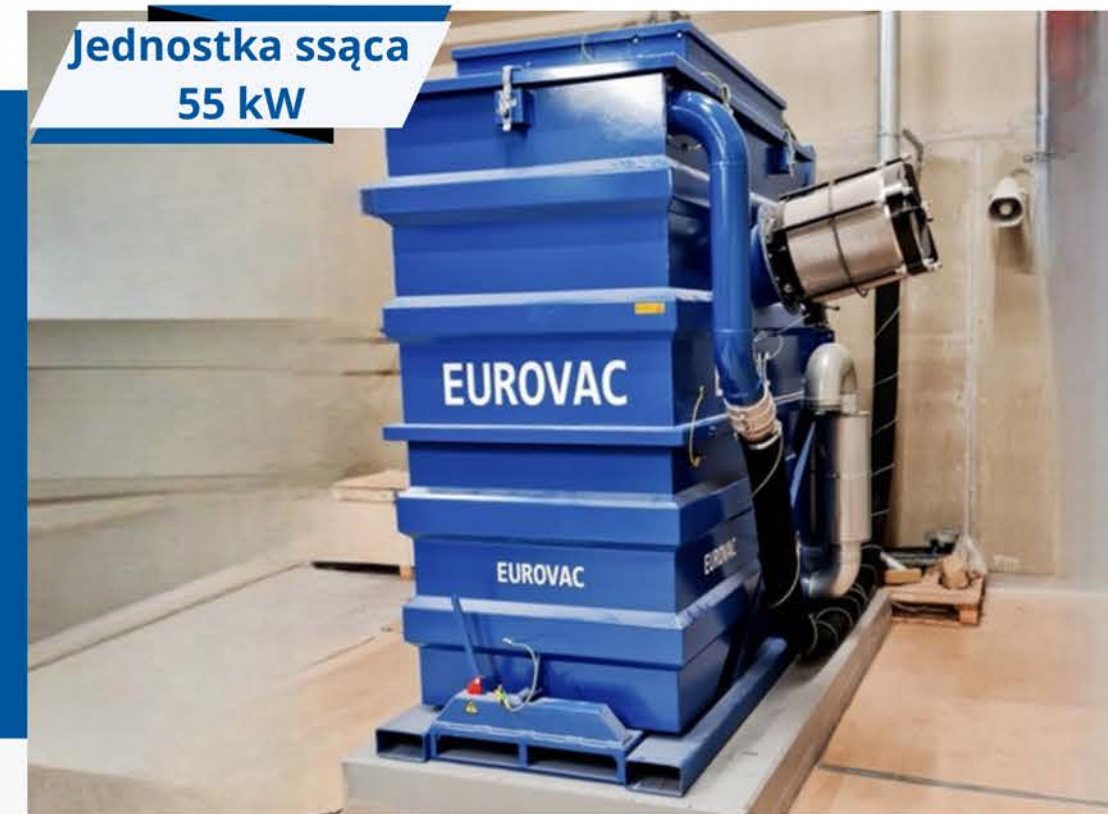
Centralny system odkurzania w ciepłowni / kotłowni
