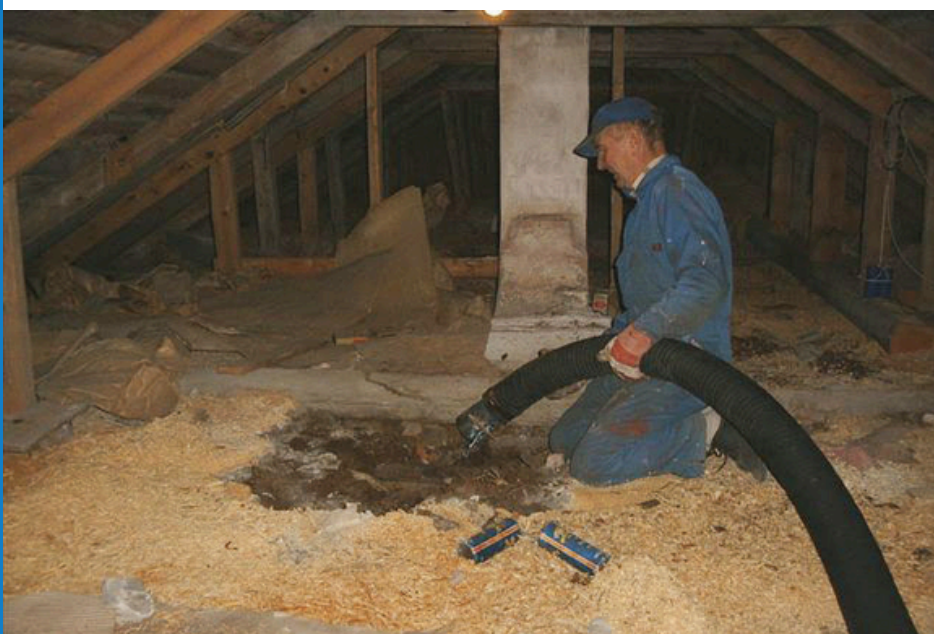
Purujen imurointia Eurovac perävaunuimurilla
