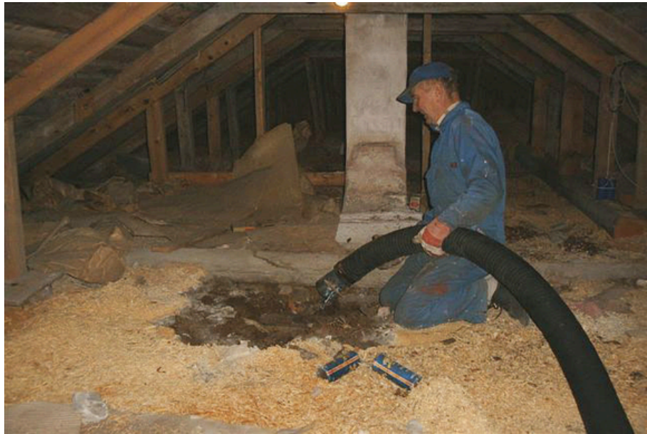
Purujen imurointia Eurovac suurtehoimurilla
