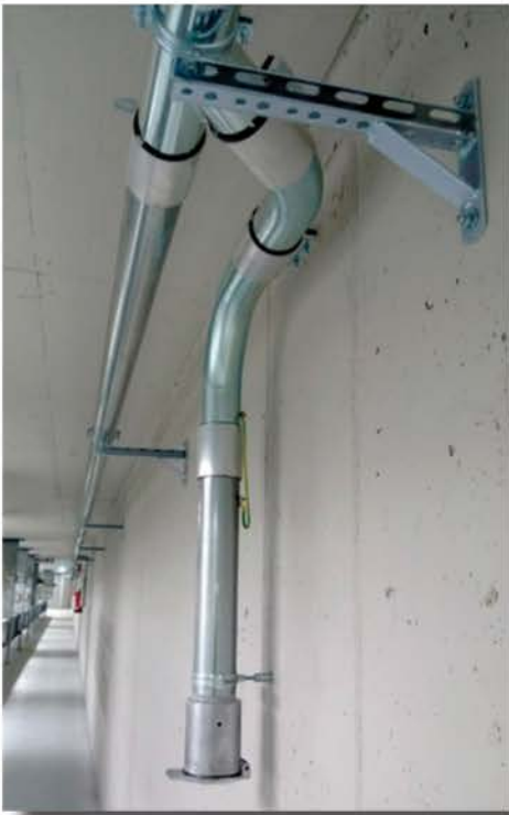
Zentralstaubsauger-Rohrleitungssystem
