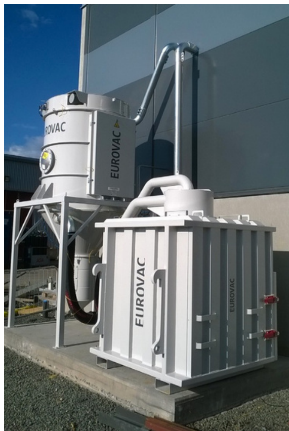
Eurovac 1400 + kontener separatora wstępnego o pojemności 3 m 3
