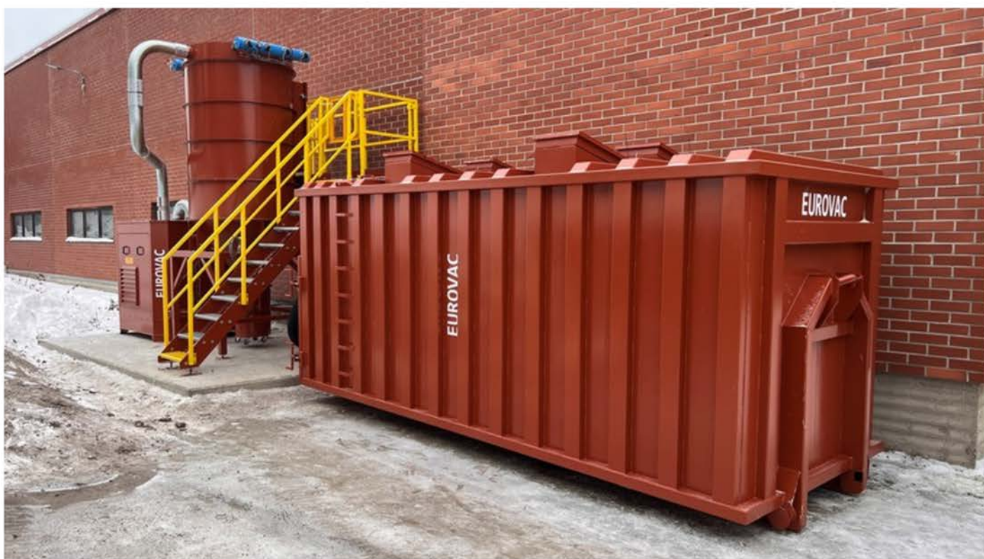
Eurovac – jednostka ssąca 55 kW z rotacyjną jednostką tłokową + jednostka ssąca 1400/32 + kontener separatora wstępnego 20 m 3
