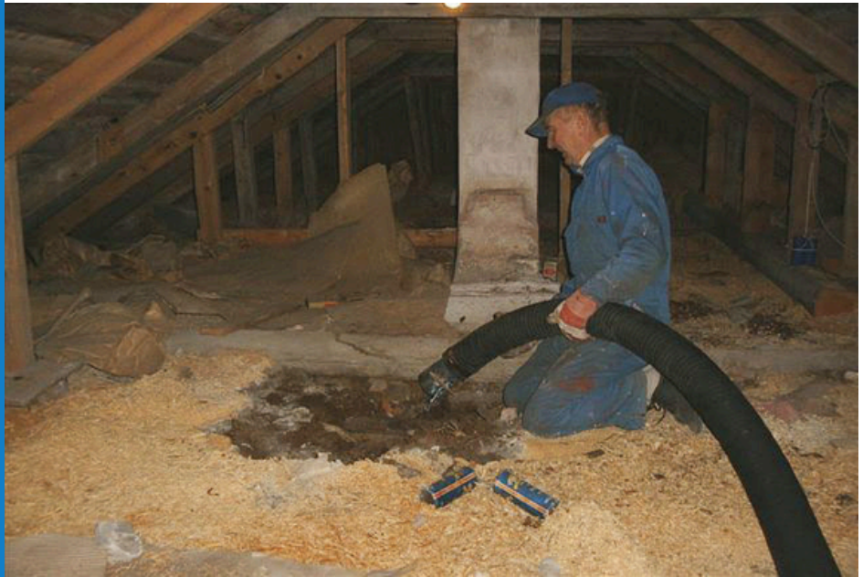
Purujen imurointia Eurovac perävaunuimurilla
